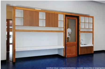
wandkast lokaal: computerwerkplekken, wastafel, berguimte en toegangspuur
